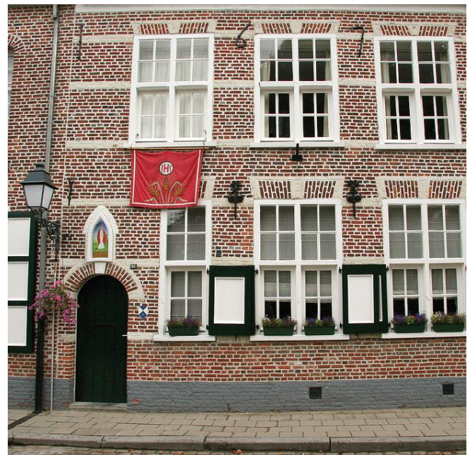
Het huis met nr. 53 en de H. Barbara boven de huisvest nu toegangsdeur dateert uit 1679, zoals blijkt uit de muurankers bovenaan.
