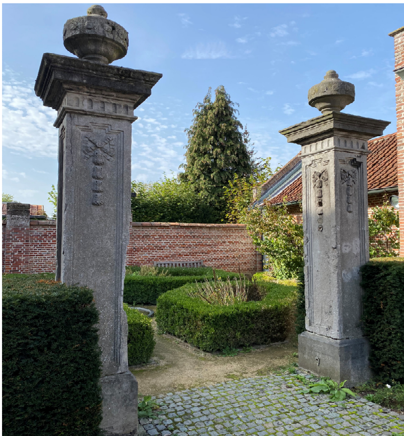
De twee hardstenen pilaren in de binnentuin van het Begijnhofmuseum (inventarisnummer B0432.1-2 en 2-2).
